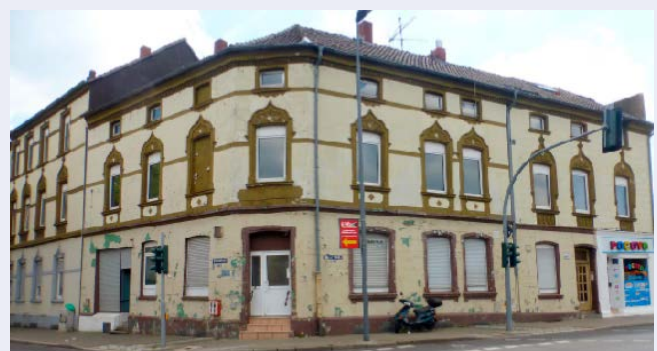
Abbildung 4: Der Verfahrensgegenstand: Problemimmobilie in der Steeler Straße 163-165. Quelle: Stadtplanungsamt Gelsenkirchen
