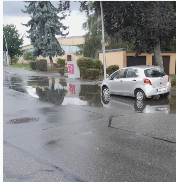
Stauwasser im Straßenraum
