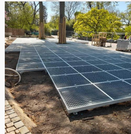
Einsatz der Wurzelbrücken
