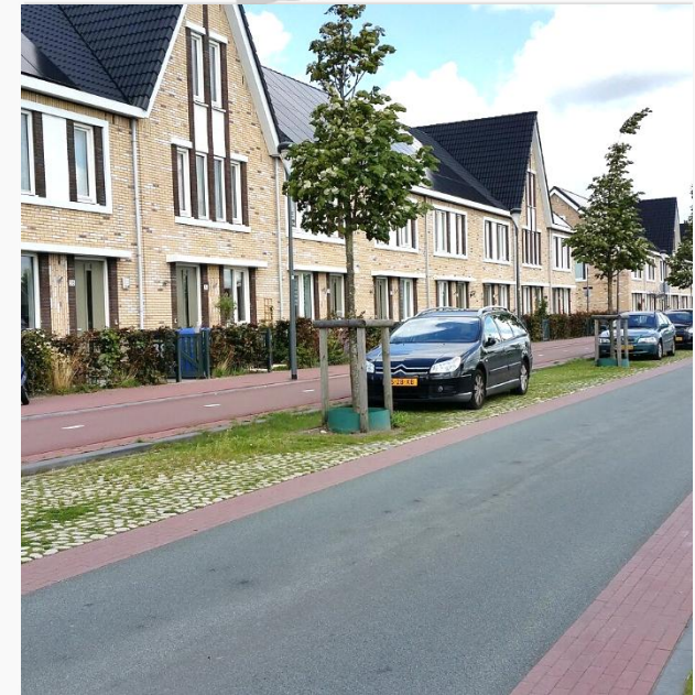
Teilentsiegelung und Begrünung einer Nebenstraße
